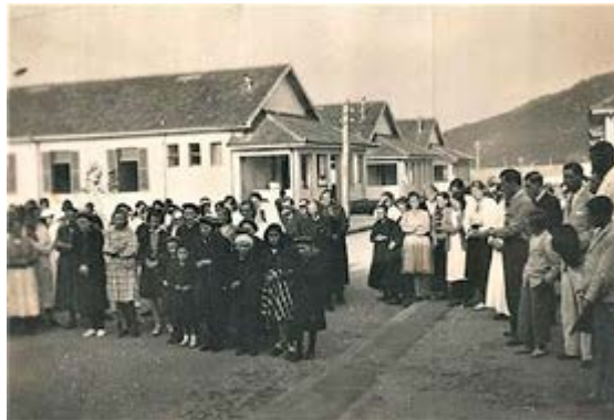
Figura 4: Aspectos dos Pavilhões “Carville”
